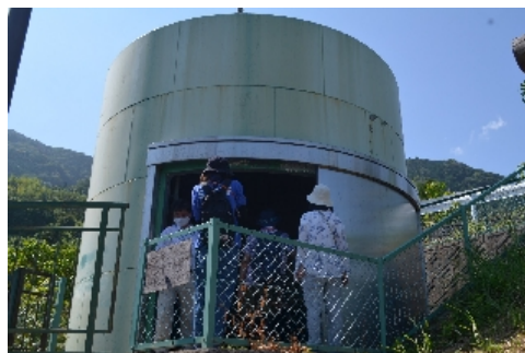
シャフト工(抑止工)
